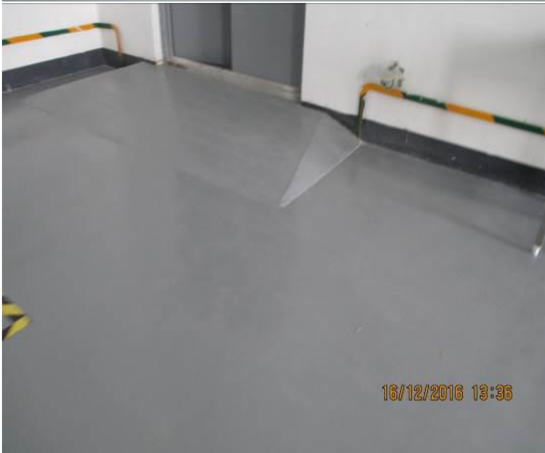
建设项目车间内防腐防渗落实情况
